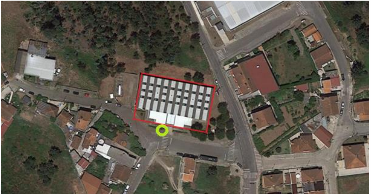
Figura 2 – Localização do hidrante exterior.
