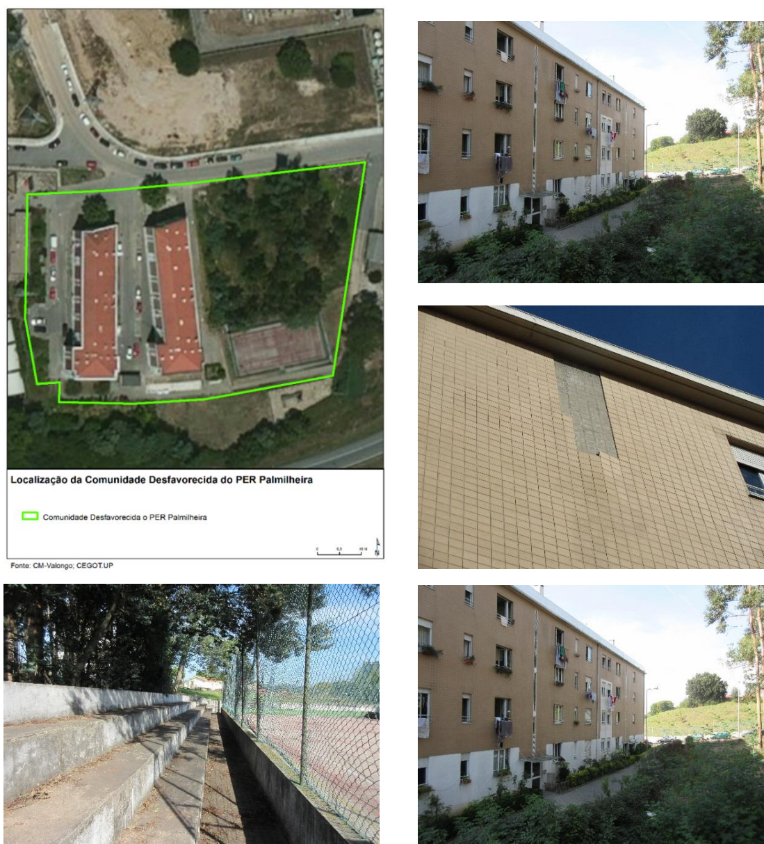
Figura 84: Localização da Com. Desfav. do PER Palmilheira e aspetos do edificado e espaço público
