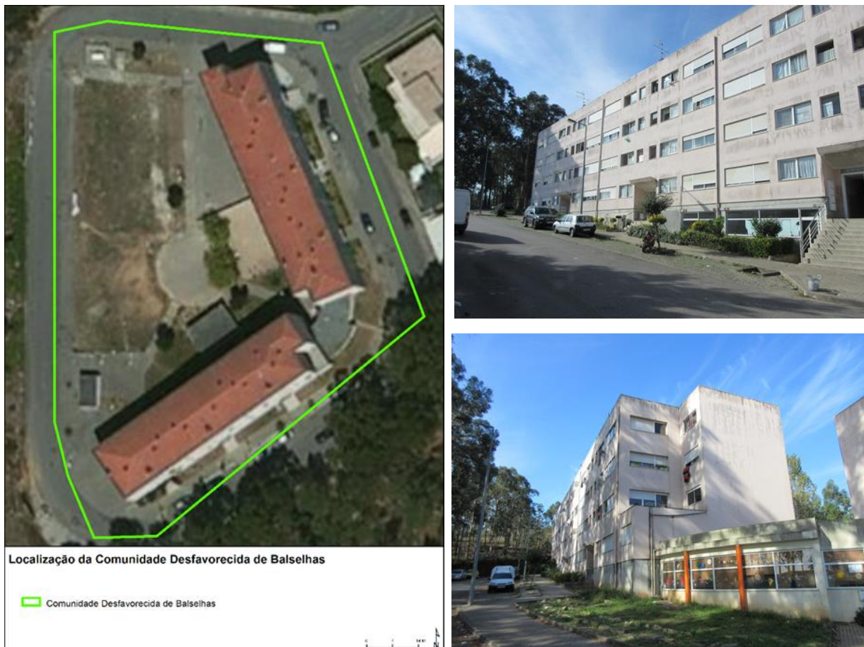
Figura 63: Localização da Comunidade Desfavorecida do Conjunto Habitacional de Balseilhas e aspetos do edificado e espaço público
