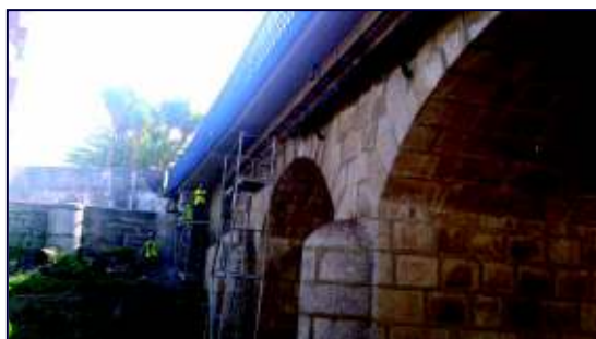
Remodelação da conduta suspensa na ponte do Rio Leça, Ermesinde;
