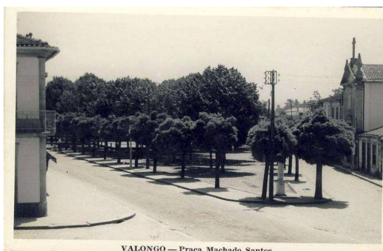
Figura 5 – Praça Machado Santos, Valongo [10]
