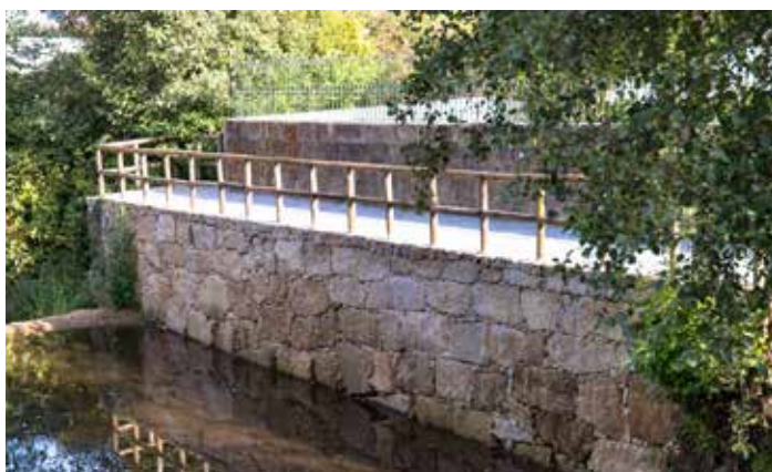
Reconstrução dos muros de contenção no Rio Leça, no Parque de São Lázaro, em Alfena
