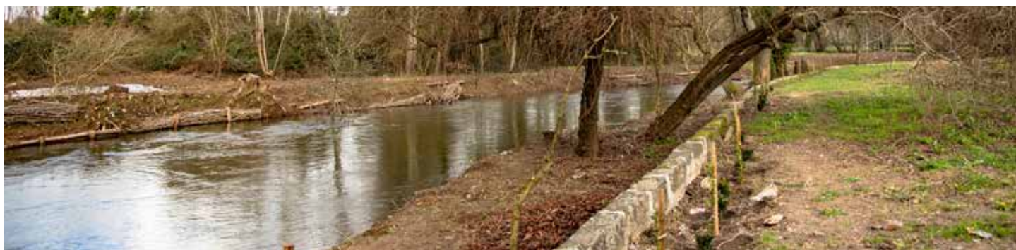
Recuperação das margens do Leça, em Ermesinde, com recurso a técnicas de engenharia natural
