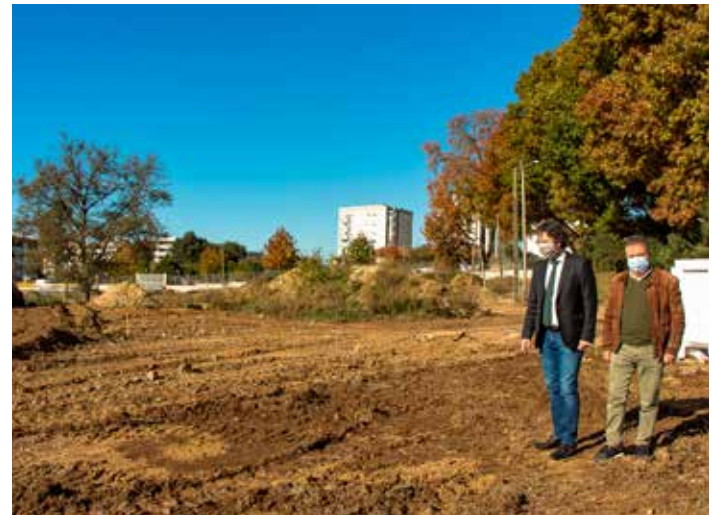
Visita às obras de terraplenagem para instalação da Horta Biológica da Palmilheira, em Ermesinde, um projeto que está a ser desenvolvido em parceria com a REN e a Lipor
