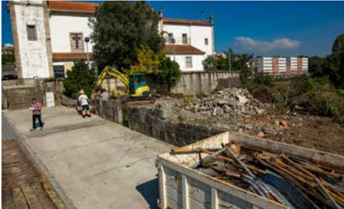
Demolição e limpeza do terreno adquirido pelo Município de Valongo para a construção da nova capela mortuária de Campo
