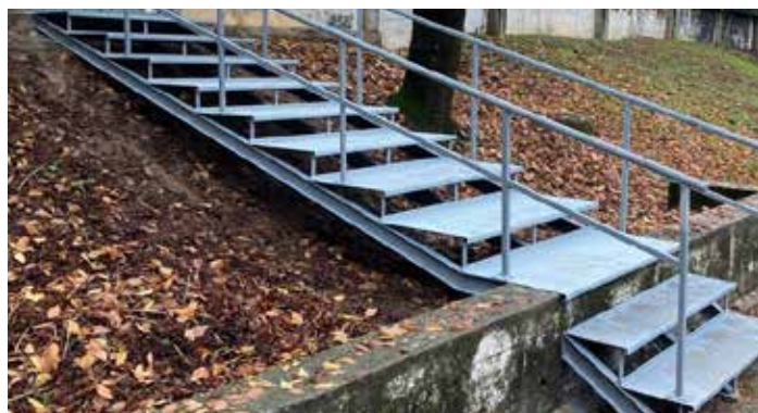
Colocação de estrutura para passagem entre o Estádio e a Escola EB2-3 Sobrado, no âmbito da reabilitação dos balneários
