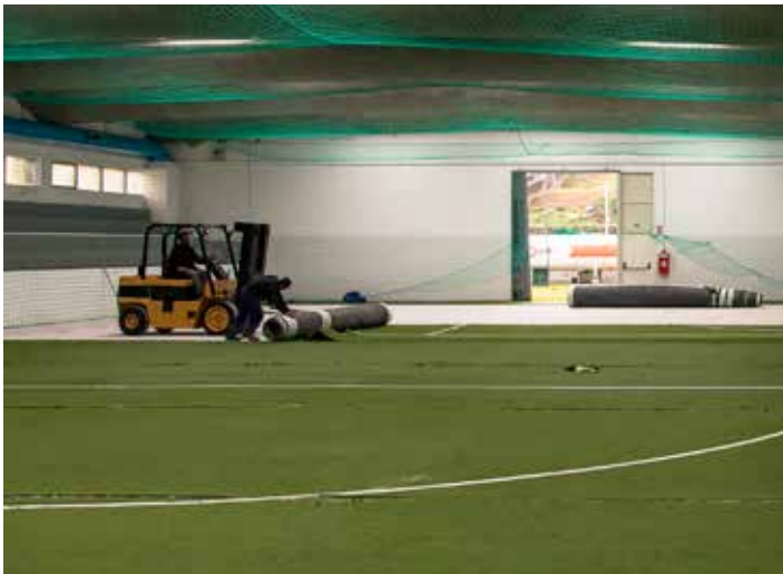
Substituição do piso do Pavilhão Indoor Soccer de Sobrado, para que este equipamento desportivo municipal fique apto para a prática de diversas modalidades desportivas, inclusive patinagem
