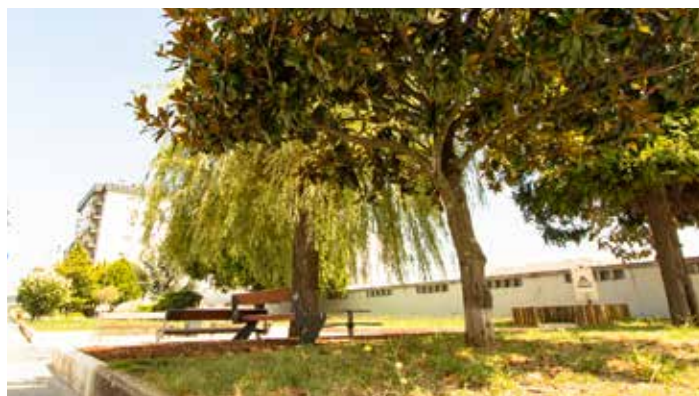
Demolição do sanitário público junto ao cemitério de Ermesinde
