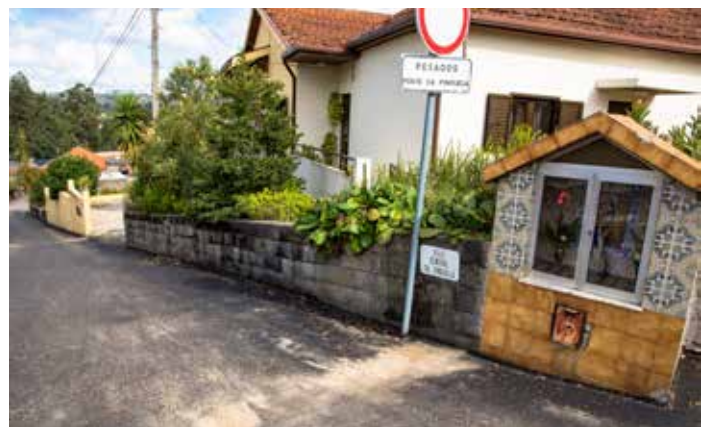
Recarga de betuminoso na Rua Central da Pinguela, em Sobrado
