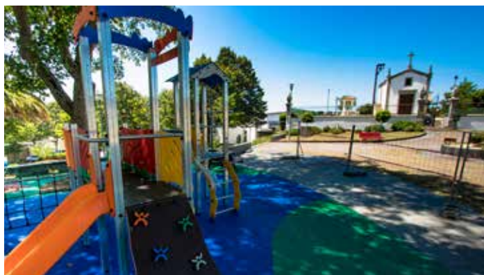
Construção de Parque Infantil do Calvário, em Valongo
