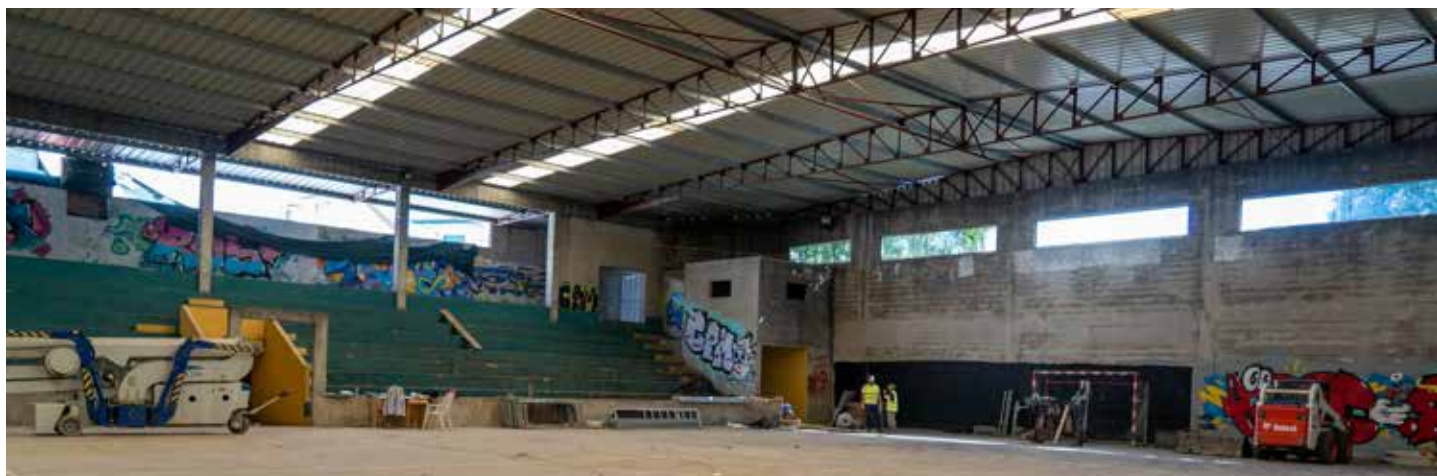
Reabilitação do Pavilhão da Bela em Ermesinde. A empreitada contempla a reformulação integral do pavilhão com a adequação dos espaços, novos balneários interiores, WC's, criação de entrada principal, cobertura nova e fachada envidraçada para o parque
