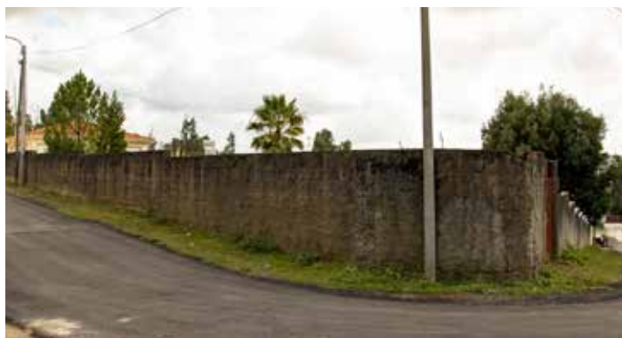
Requalificação do piso da Travessa da Virela, em Valongo
