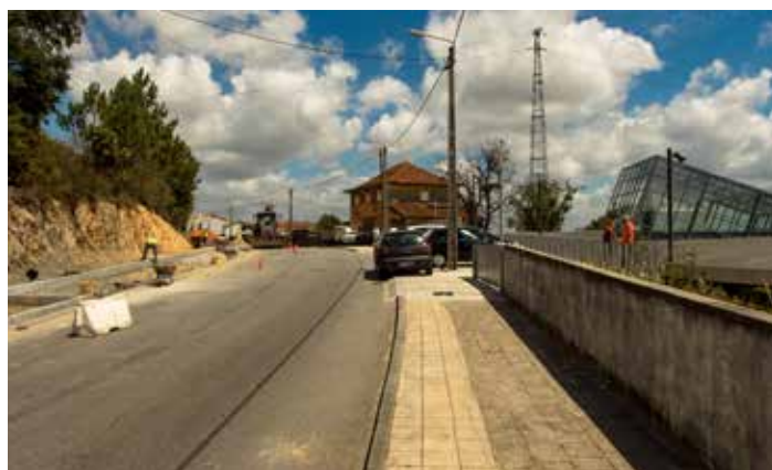
Construção do parque de estacionamento da Unidade de Saúde de Campo
