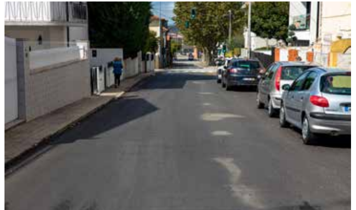
Requalificação da Rua Almeida Garrett, em Ermesinde
