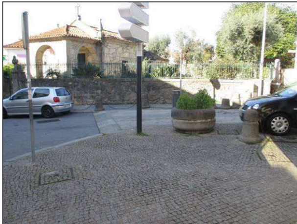
Figura 43. Exemplo de sinal de trânsito a obstruir o percurso acessível
