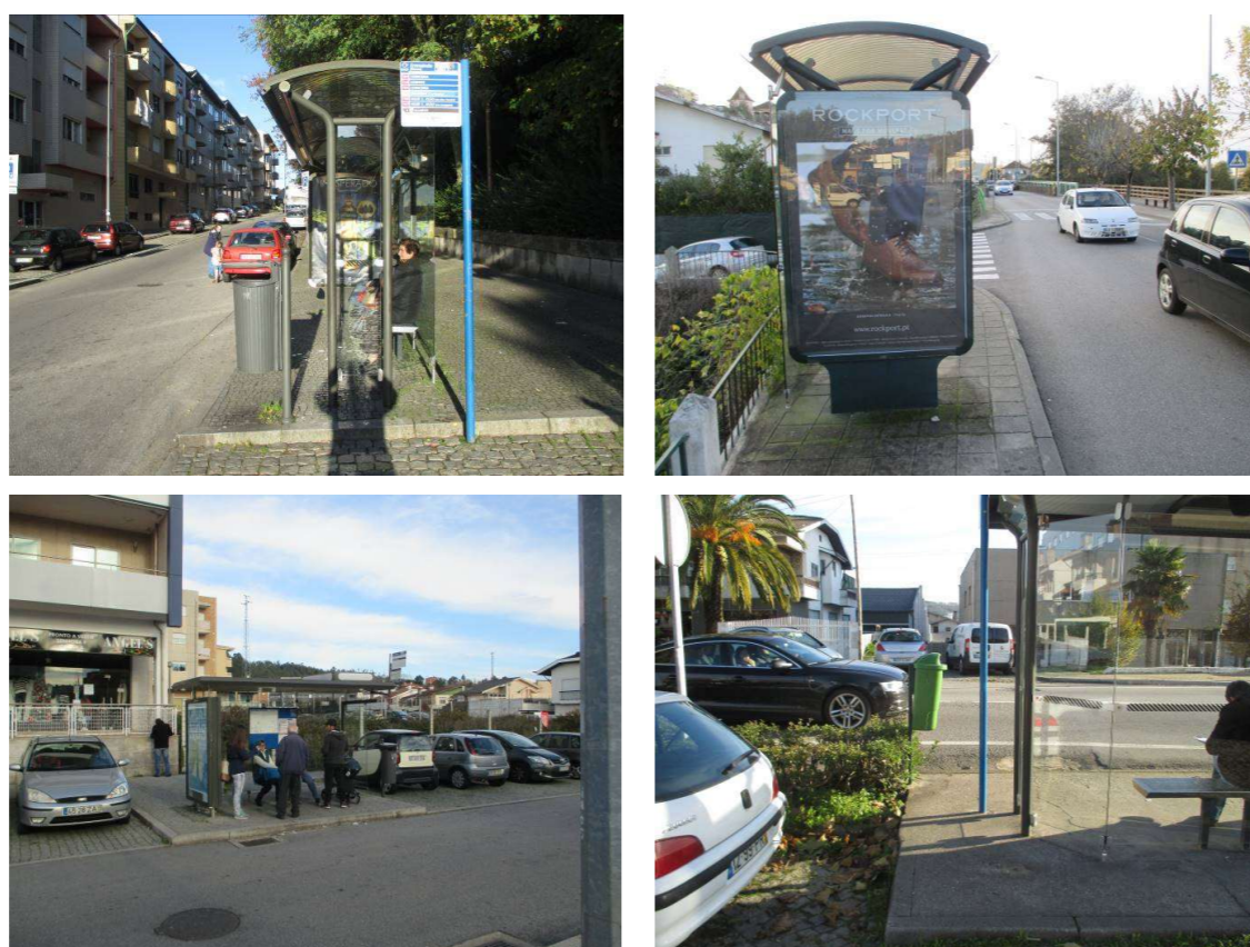
Figura 86. Interior das infraestruturas de apoio ao transporte coletivo rodoviário inacessíveis
