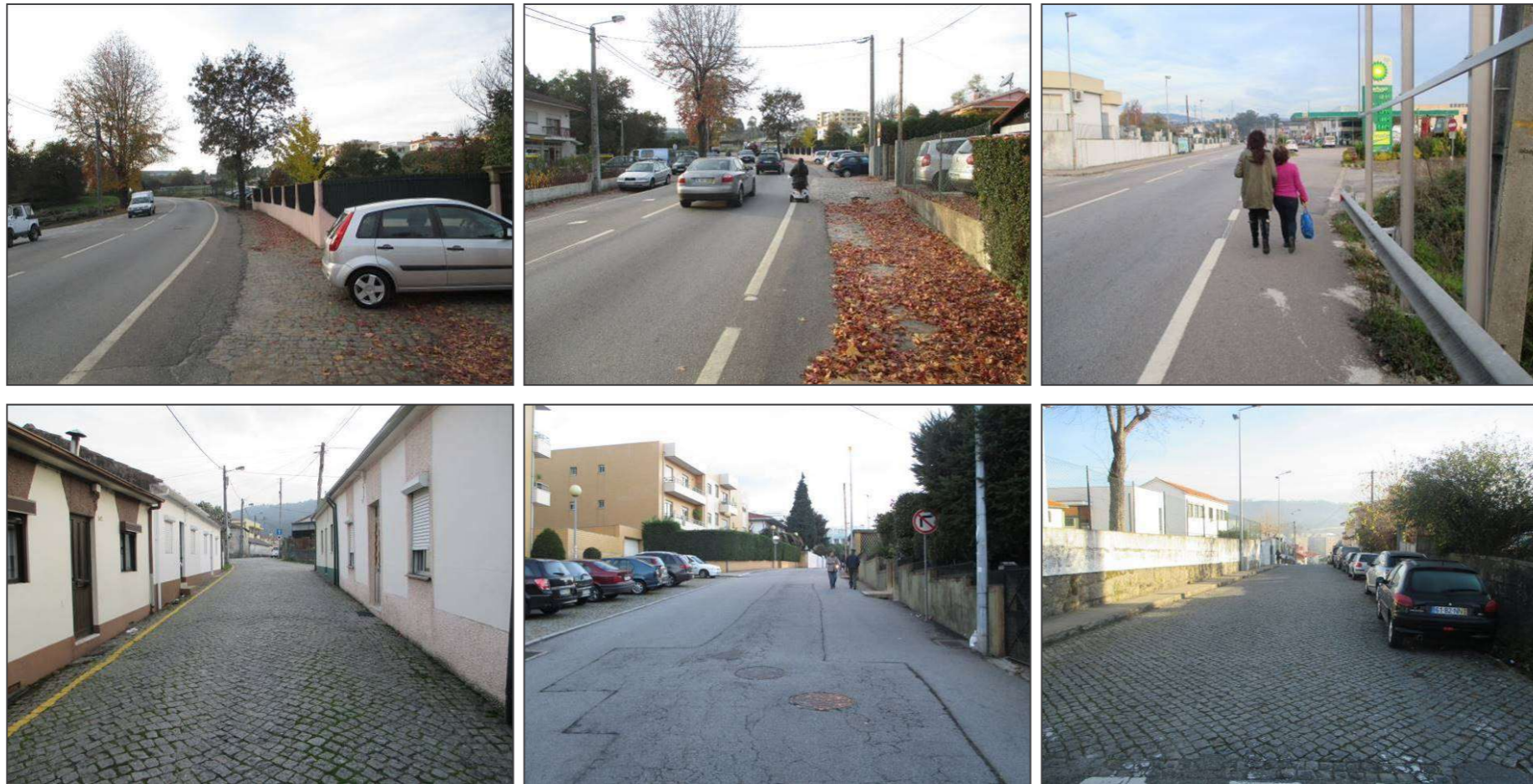
Figura 40. Exemplos de ausência de passeio a obstruir o percurso acessível
