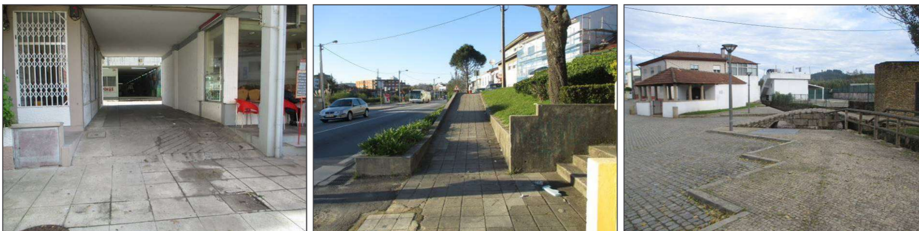
Figura 34. Exemplos de rampa a obstruir o percurso acessível
