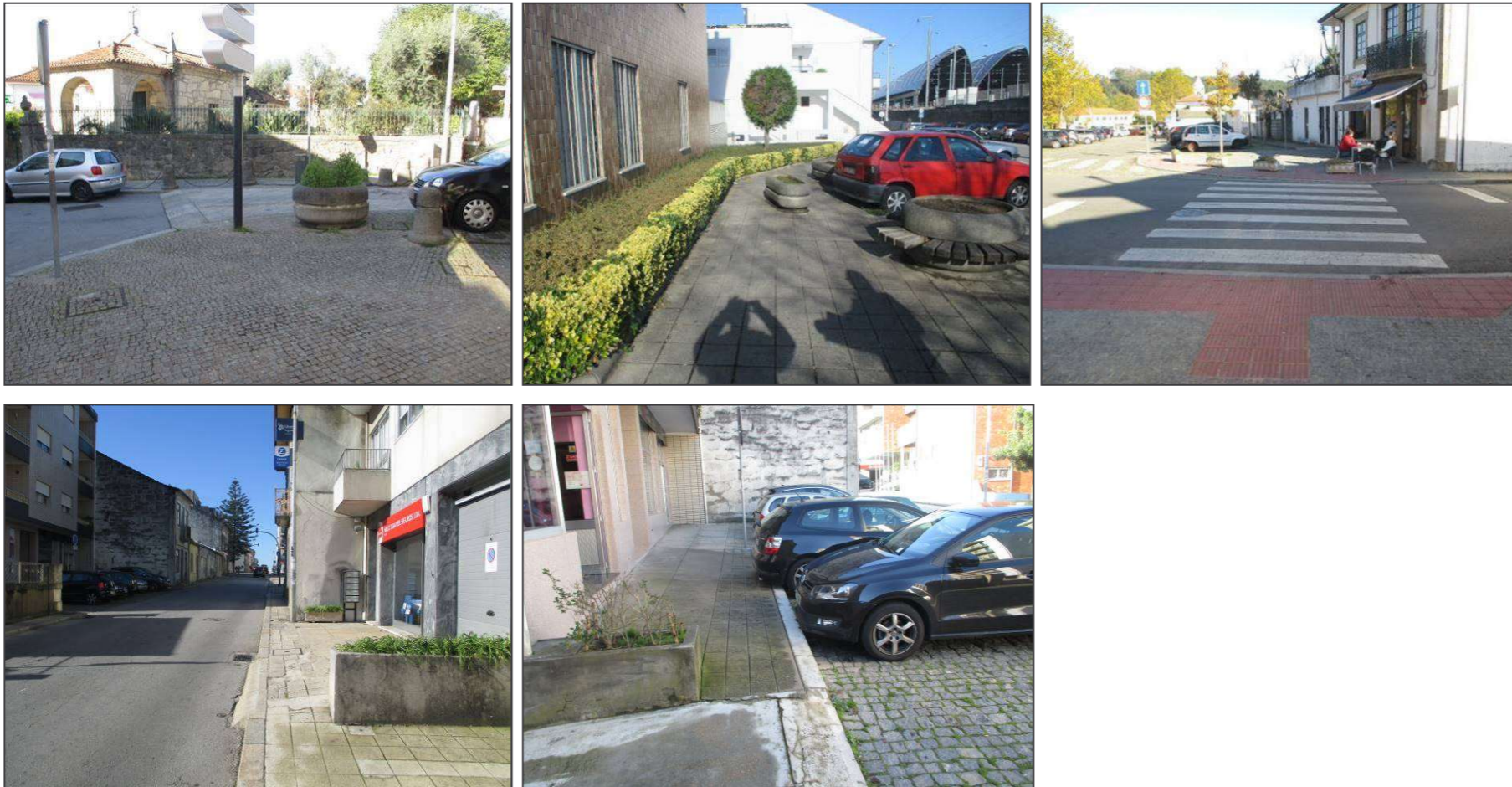
Figura 35. Exemplos de floreira a obstruir o percurso acessível
