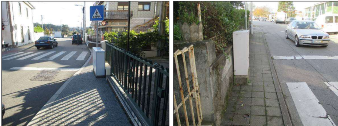
Figura 26. Exemplos de armário a obstruir o percurso acessível
