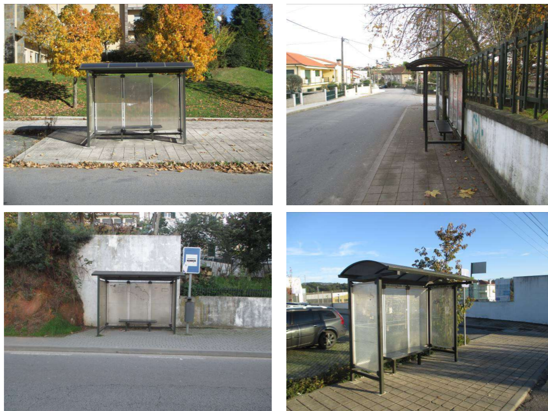
Figura 87. Inexistência de local de permanência no interior das infraestruturas de apoio ao transporte coletivo rodoviário
