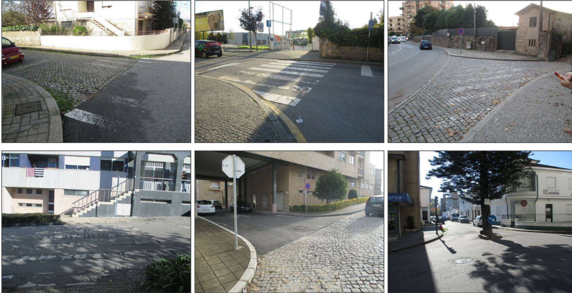
Figura 37. Exemplos de ausência e pintura degradada das passeadeiras a obstruir o percurso acessível
