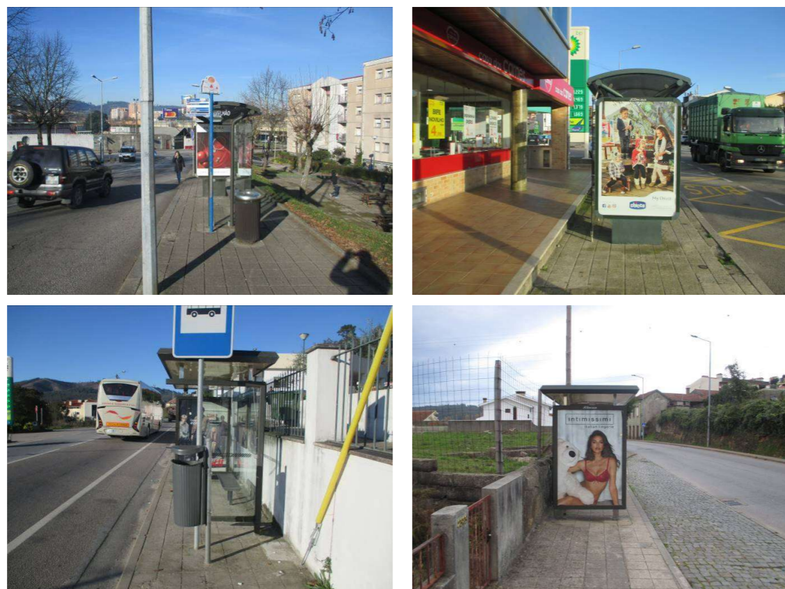
Figura 83. Infraestruturas de apoio ao transporte coletivo rodoviário a obstruir o percurso acessível
