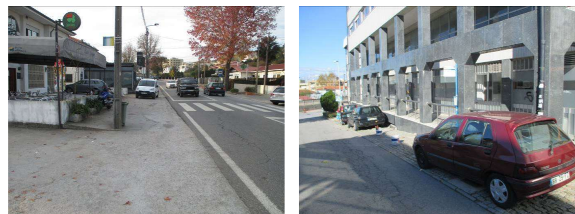
Figura 84. Inexistência de Plataforma nas Infraestruturas de apoio ao transporte coletivo rodoviário
