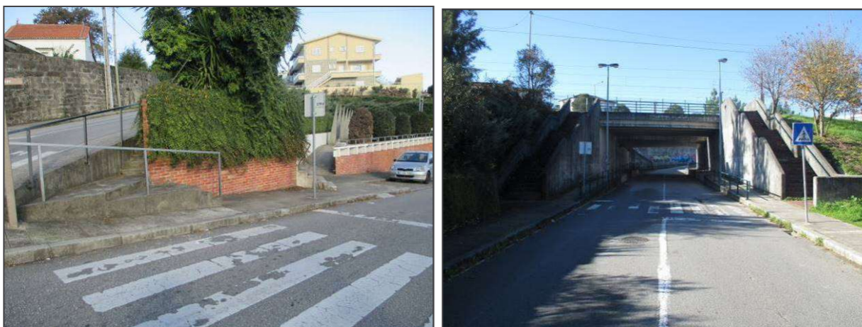
Figura 32. Exemplos de escadas a obstruir o percurso acessível
