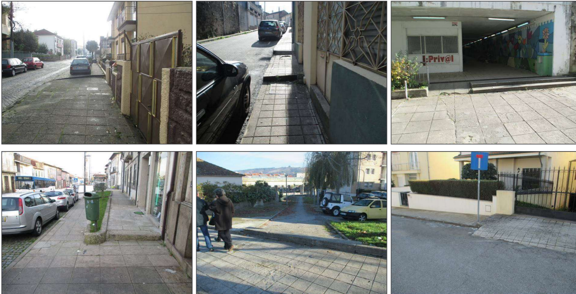
Figura 33. Exemplos de degraus a obstruir o percurso acessível
