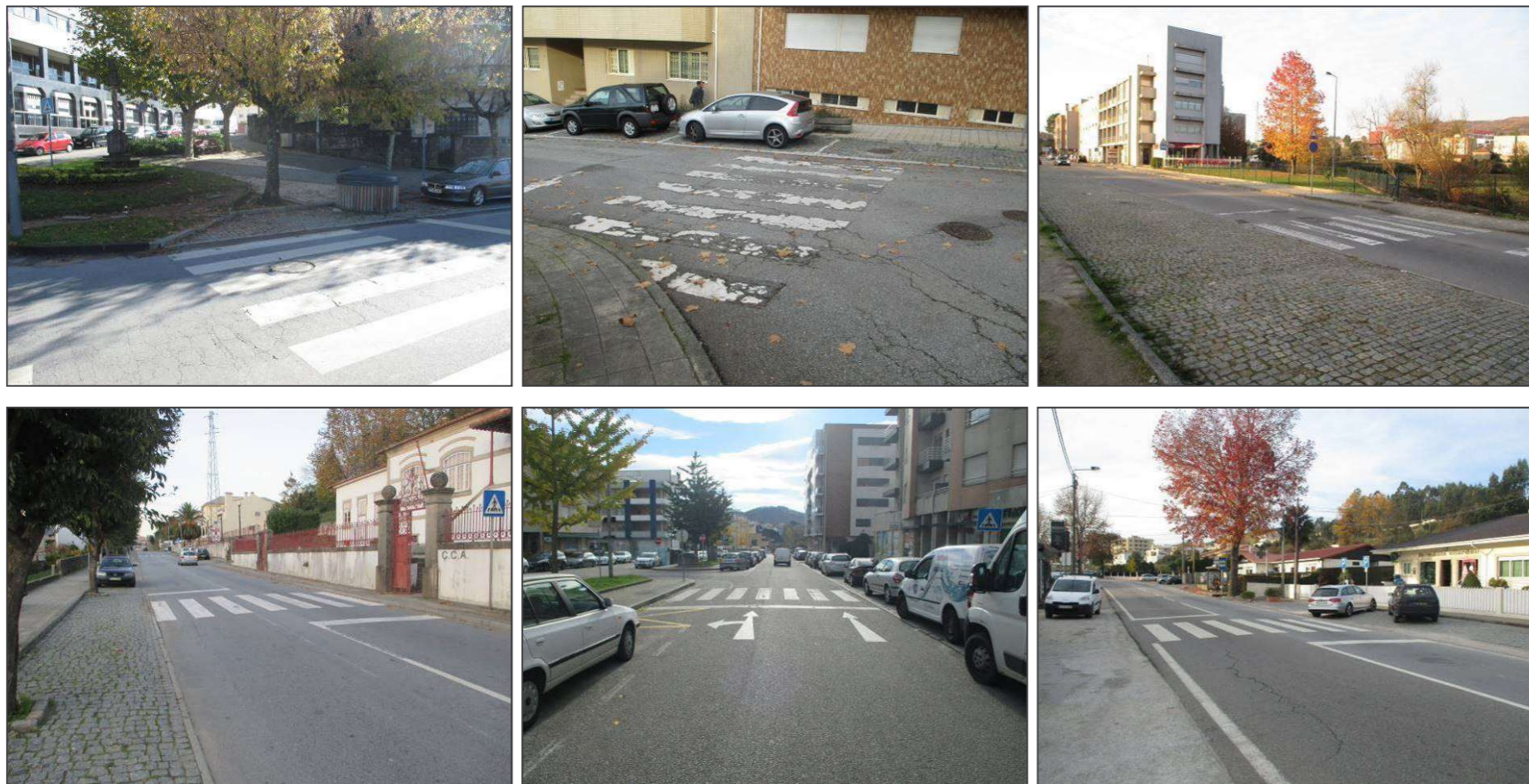
Figura 39. Exemplos de passadeira a terminar em estacionamento a obstruir o percurso acessível
