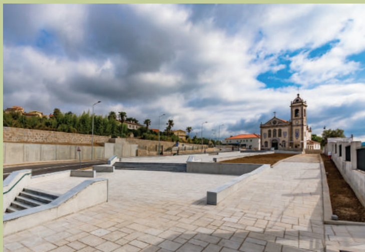
Construção da Nova Alameda de Campo ▲
