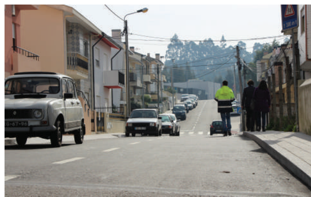
▲ Reabilitação dos arruamentos do lugar de Sonhos, em Ermesinde
