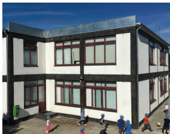
▲ Nova cobertura e pintura da Escola da Azenha, em Campo
