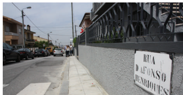
▲ Restauro do passeio na rua D. Afonso Henriques, em Ermesinde
