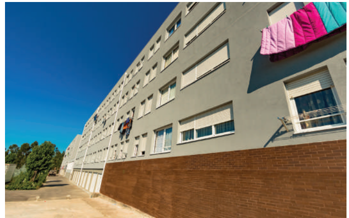
▲ Requalificação do Empreendimento do Barreiro, em Alfena
