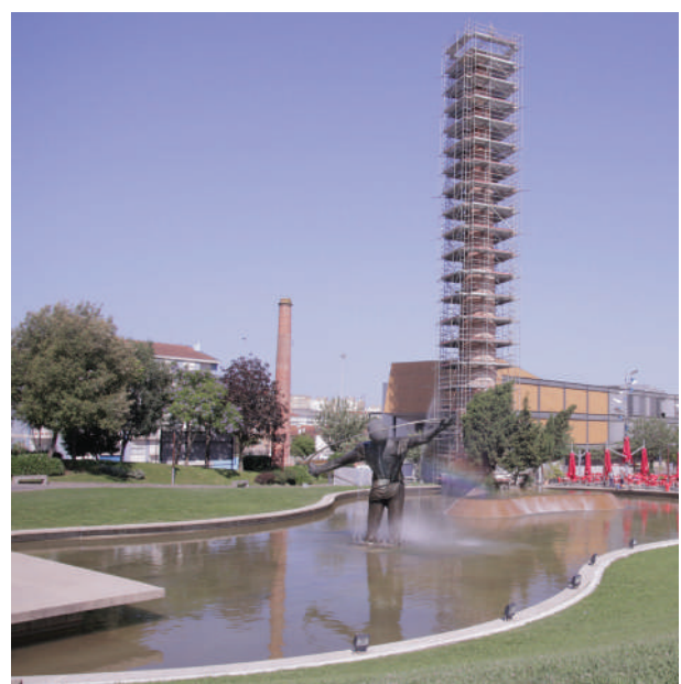
▲ Estabilização da chaminé e recuperação do lago do Parque Urbano de Ermesinde
