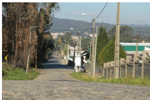
▲ Reparação da Rua Central da Fervença, em Campo
