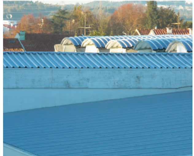
▲ Substituição da cobertura das Piscinas Municipais de Ermesinde
