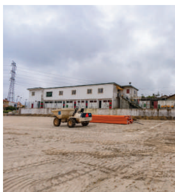
▲ Início da construção do relvado sintético de Campo
