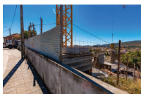
▲ Apoio para instalação do novo Centro de Saúde de Campo
