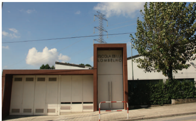
▲ Intervenção na Escola do Lombelho, em Alfena
