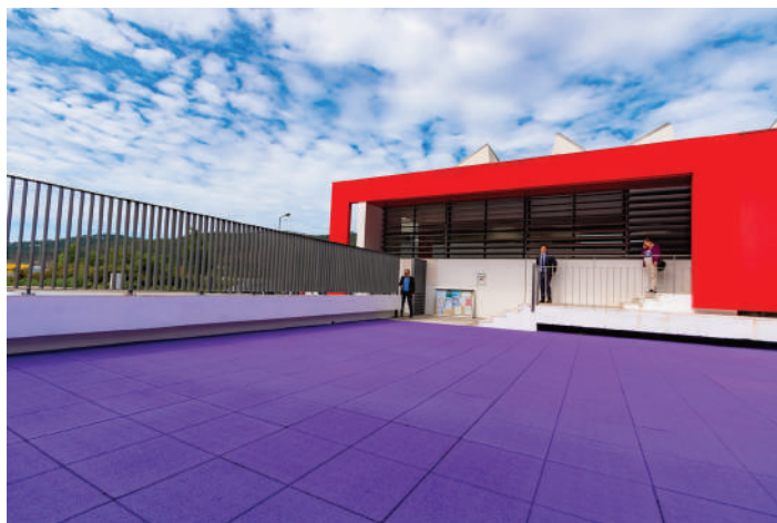
▲ Reformulação da entrada da Escola da Estação, em Valongo
