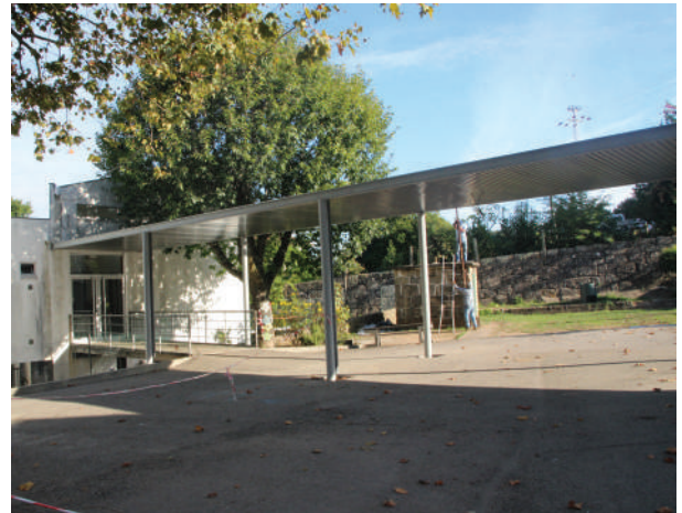
▲ Nova cobertura da Escola da Costa, em Ermesinde
