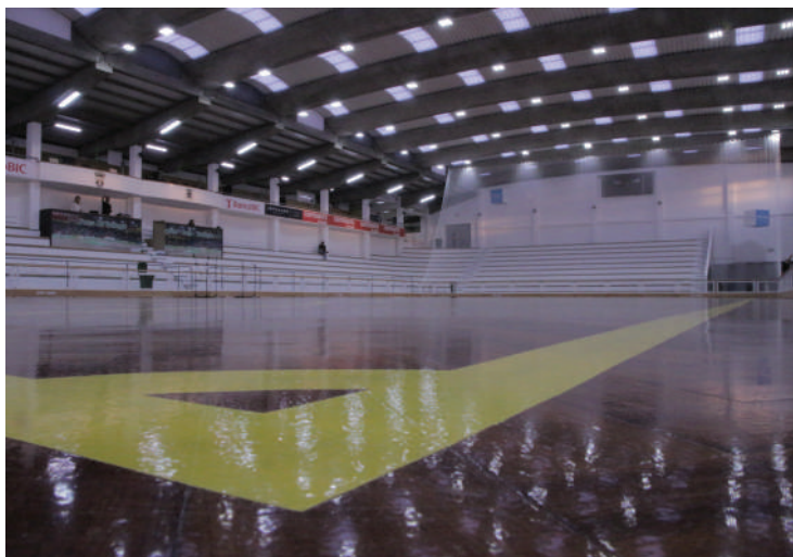
▲ Renovação do Pavilhão Municipal de Valongo
