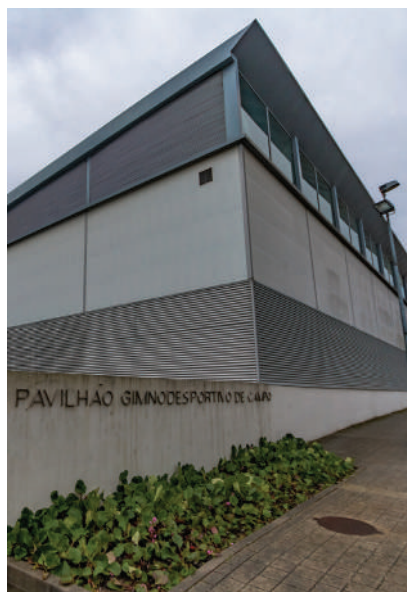
◀ Reparação da Cobertura do Pavilhão de Campo
