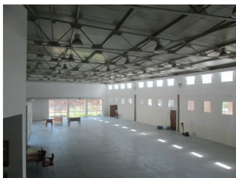
◀ Recuperação dos espaços interiores e exteriores da Escola Profissional de Valongo
