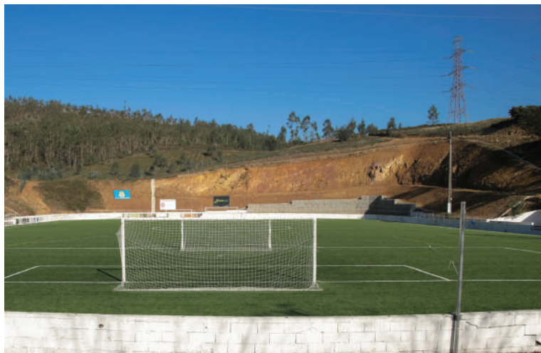
▲ Consolidação de taludes e relvado sintético do Estádio de Sobrado
