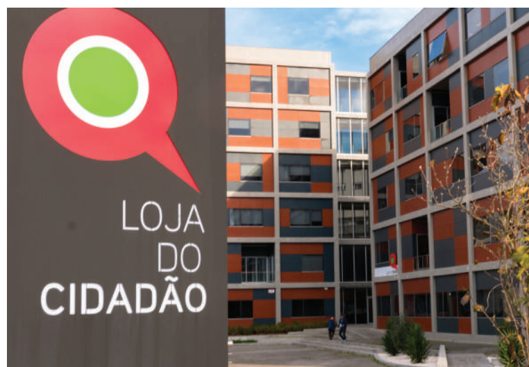
▲ Conclusão do Edifício Faria Sampaio para instalação da Loja do Cidadão, em Ermesinde
