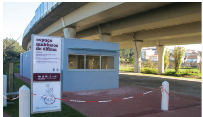
▲ Construção do espaço Multiusos de Alfena e criação de lugares de estacionamento, permitindo a instalação da feira semanal
