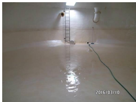
RESERVATORIO DA GANDRA – ALFENA DEPOIS DA LIMPEZA E DESINFEÇÃO
