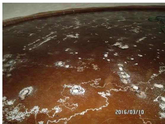
RESERVATORIO DA GANDRA – ALFENA ANTES DA LIMPEZA E DESINFEÇÃO
