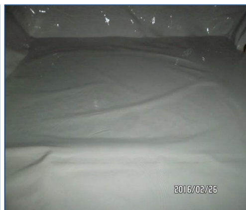
CISTERNA PREDIAL DEPOIS DA LIMPEZA E DESINFEÇÃO
