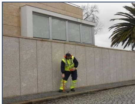
Atividade de deteção de fugas
