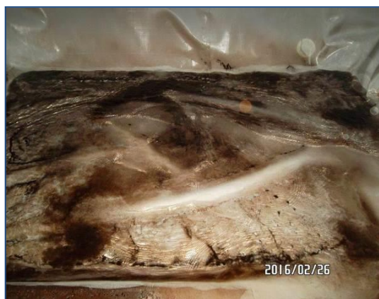
CISTERNA PREDIAL DEPOIS DA LIMPEZA E DESINFEÇÃO
