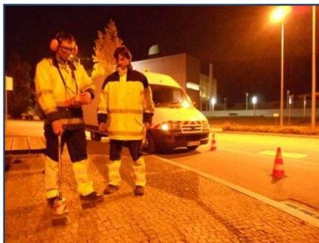
Atividade de deteção de fugas
