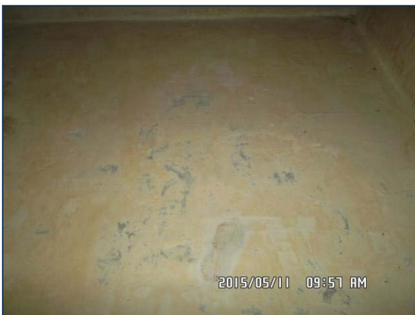
RUA LAMEIRA DEPOIS DA LIMPEZA E DESINFECÇÃO
