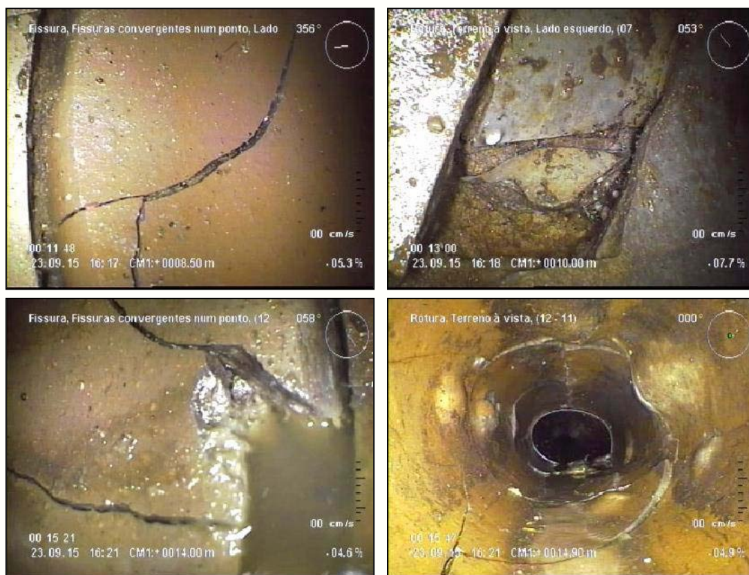
Rua Rodrigues de Freitas, Ermesinde – coletores em grés
