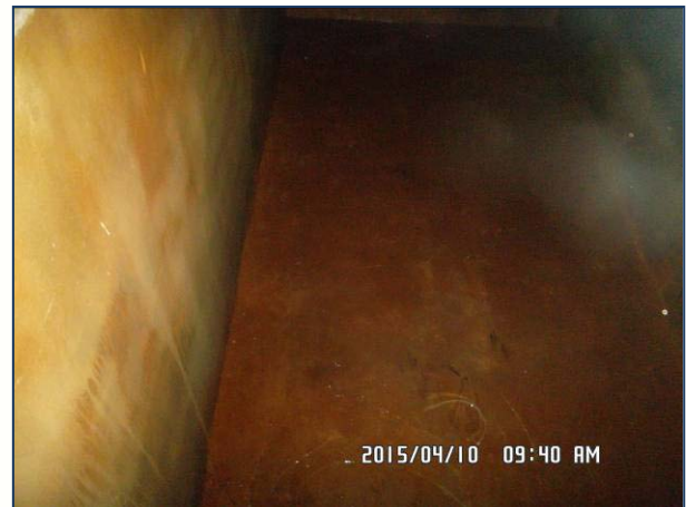
RUA MANUEL ARRIAGA ANTES DA LIMPEZA E DESINFECÇÃO
