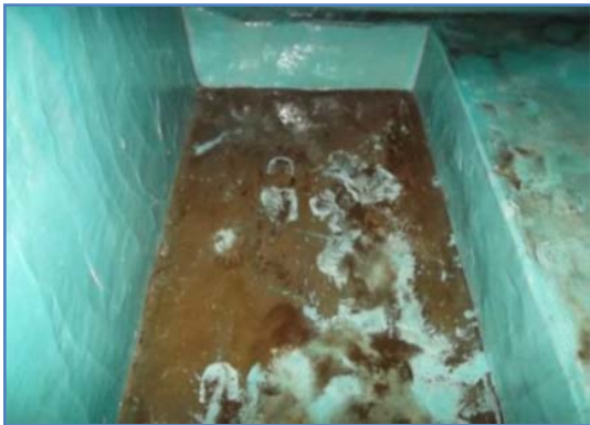
RUA ALDEIA LAVRADORES ANTES DA LIMPEZA E DESINFEÇÃO
