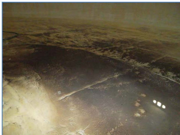
RESERVATORIO MONTES DA COSTA ANTES DA LIMPEZA E DESINFEÇÃO
