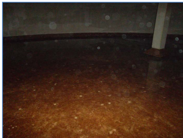
RESERVATORIO DA CANA ANTES DA LIMPEZA E DESINFEÇÃO
