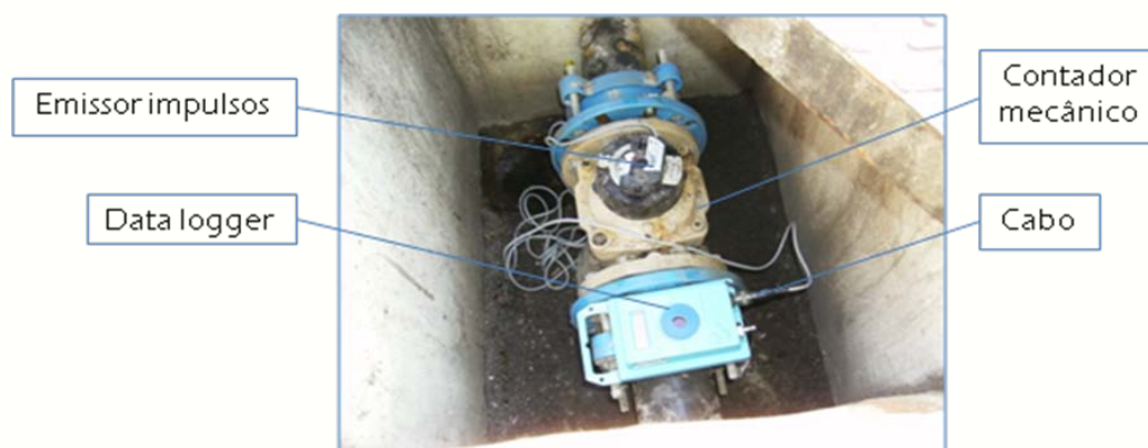
Registo de caudais numa ZMC com um contador mecânico (exemplo)
