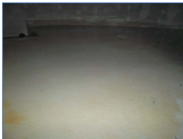
RESERVATORIO DA CANA DEPOIS DA LIMPEZA E DESINFEÇÃO
