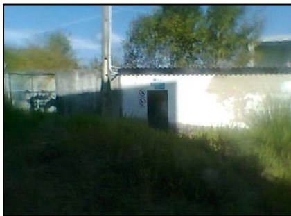
Central Elevatória dos Bacelos desativada.
