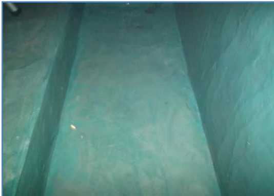
RUA ALDEIA LAVRADORES DEPOIS DA LIMPEZA E DESINFEÇÃO
