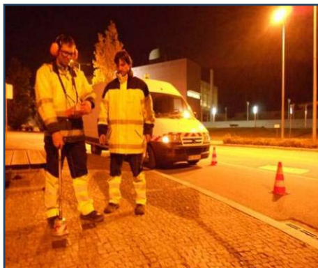
Atividade de deteção de fugas
