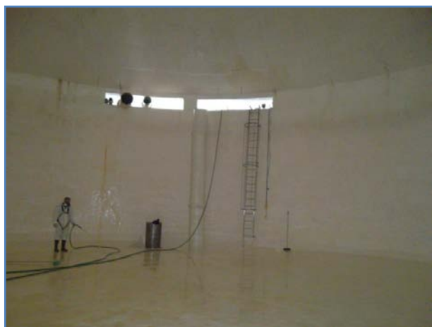
RESERVATORIO MONTES DA COSTA DEPOIS DA LIMPEZA E DESINFEÇÃO
