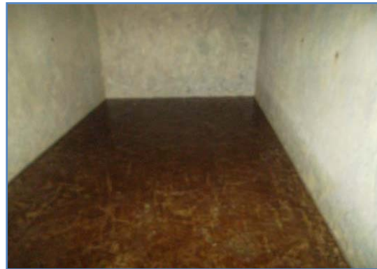
RUA CABEDA ANTES DA LIMPEZA E DESINFEÇÃO
